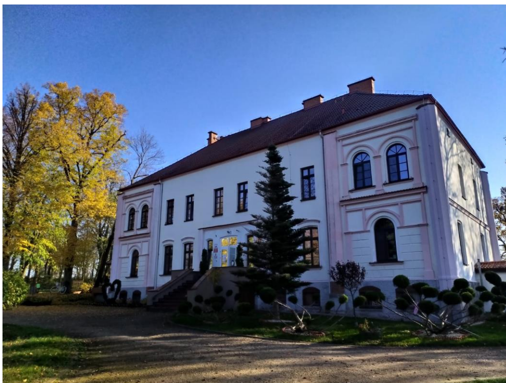
Zdjęcie nr 1. Pałac - budynek główny
