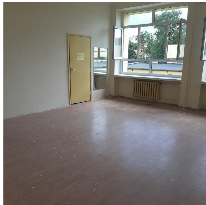
POKÓJ NAUCZYCIELSKI - W TRAKCIE REMONTU (GIPSOWANIE, GŁADZENIE, MALOWANIE, WYMIANA PODŁOGI - PANELE)
