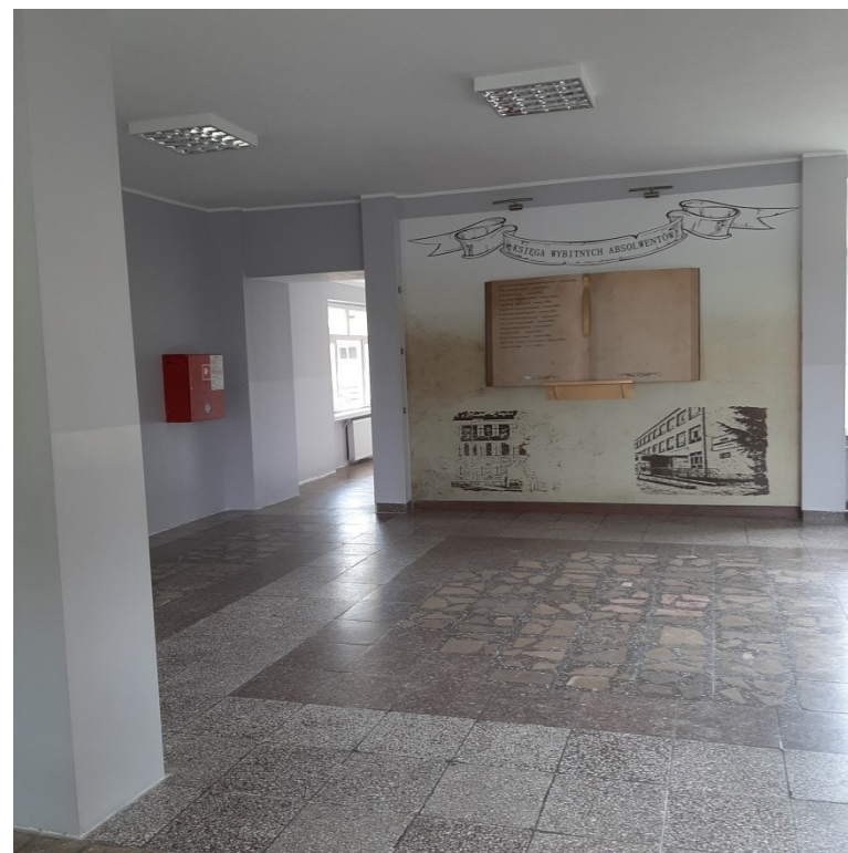
HOL GŁÓWNY (ZBICIE PŁYT ZE ŚCIAN, GIPSOWANIE, GŁADZENIE, MALOWANIE ŚCIAN, WYMIANA DRZWI W ŁAZIENKACH, W POMIESZCZENIU SOCJALNYM, WYMIANA OŚWIETLANIA)
