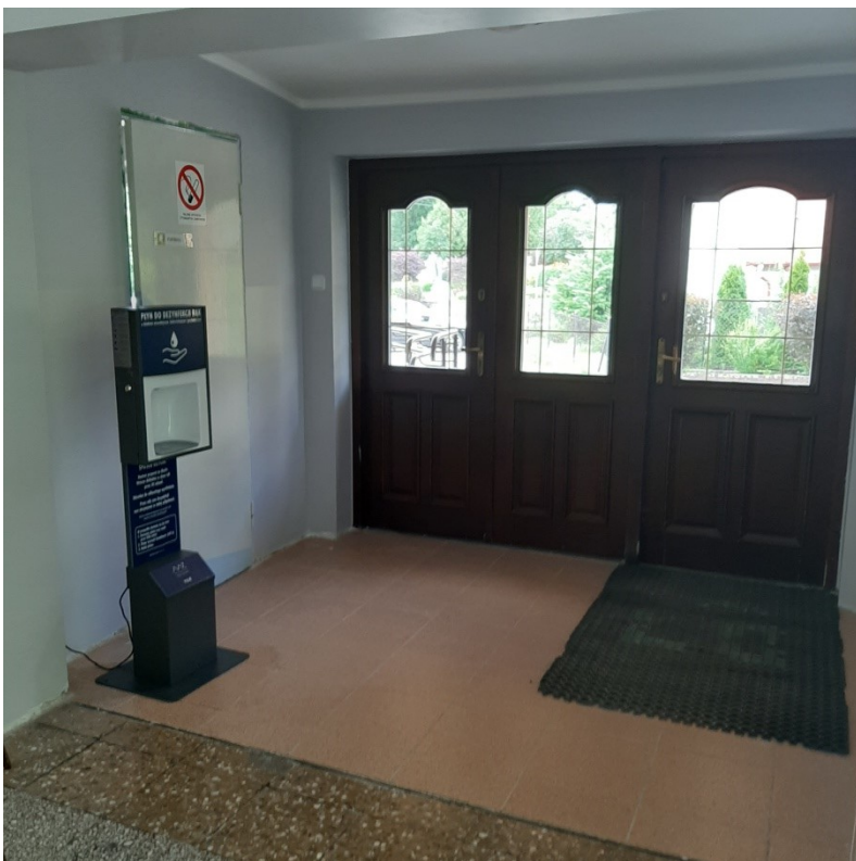
KORYTARZYK PRZY WEJŚCIU DO SZKOŁY (ZERWANIE PANELI ŚCIENNYCH, GIPSOWANIE, GŁADZENIE, MALOWANIE)
